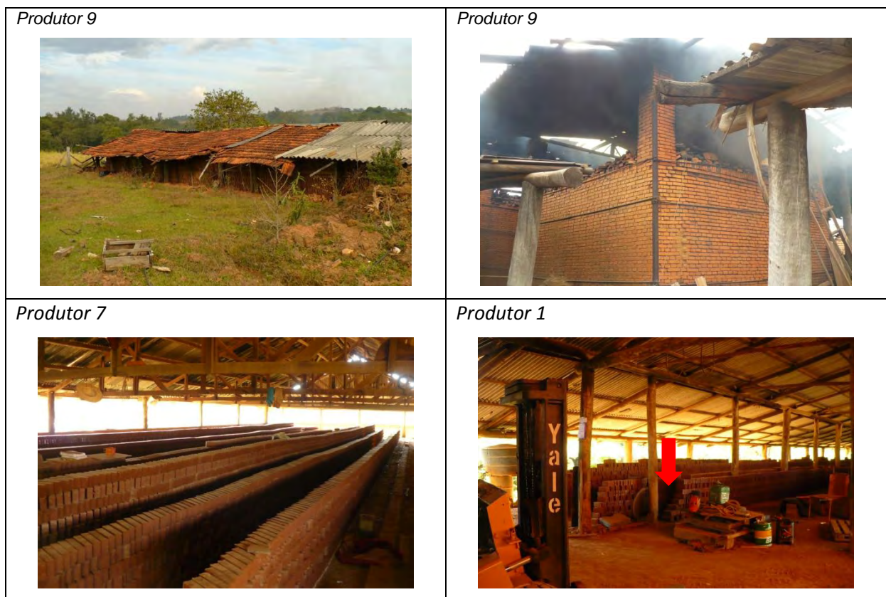
Figura 35 - Condições insuficientes das instalações dos produtores. Barracão em estado de ruína precário, iluminação insuficiente, telhado do forno em condições de risco de incêndio, tambores e objetos pessoais dos funcionários espalhados pela área de produção. (Fotos do autor – 30/06/11).
