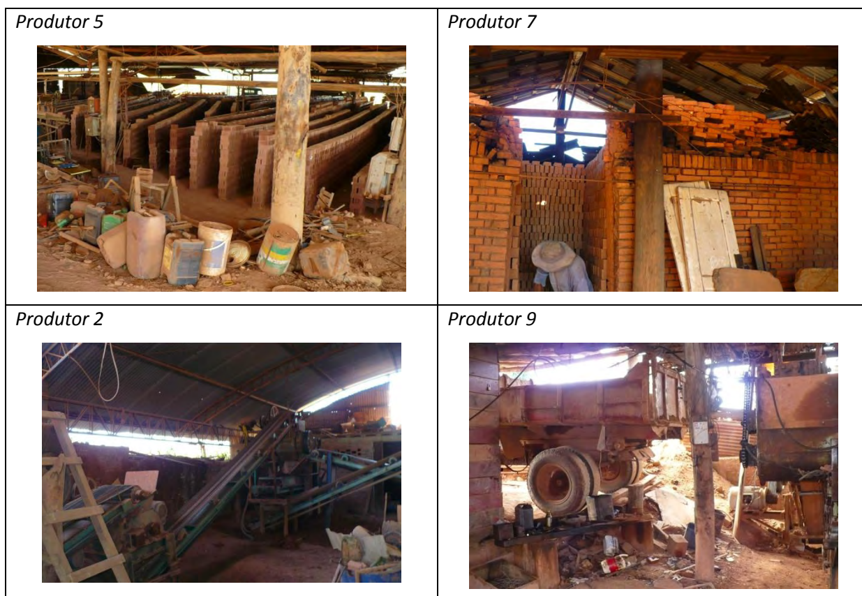
Figura 36 - Condições insuficientes das instalações dos produtores. Entulhos e tambores espalhados pela área de produção, funcionário sem equipamentos de proteção, equipamentos da produção sem dispositivos de proteção contra acidentes e painéis com fiação elétrica exposta. (Fotos do autor 30/06/11).
