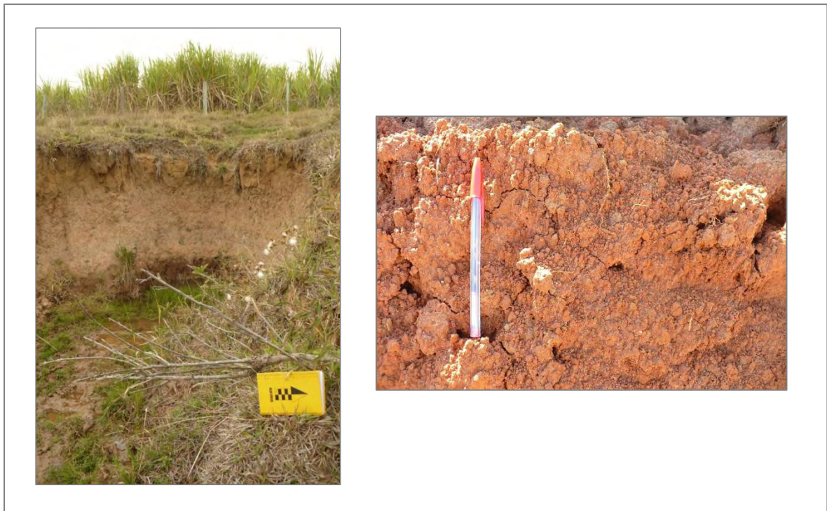
Figura 4 - Manto intemperizado da Formação Corumbataí. (Fotos do autor – 06/08/10)
