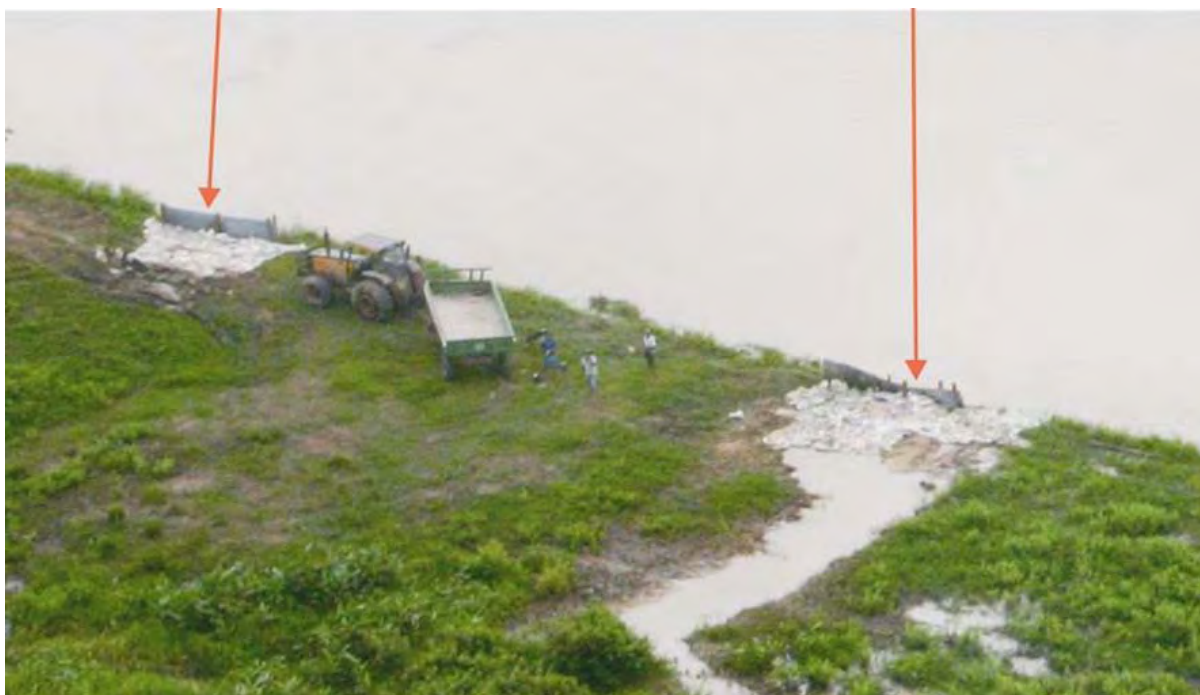
Figura 55. Construção de barragens próximas à Fazenda Caronal. (Foto AHIPAR)
