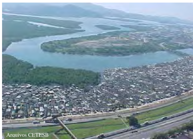
Figura 35: Casas em área aterrada sobre manguezal (Vila dos Pescadores).
