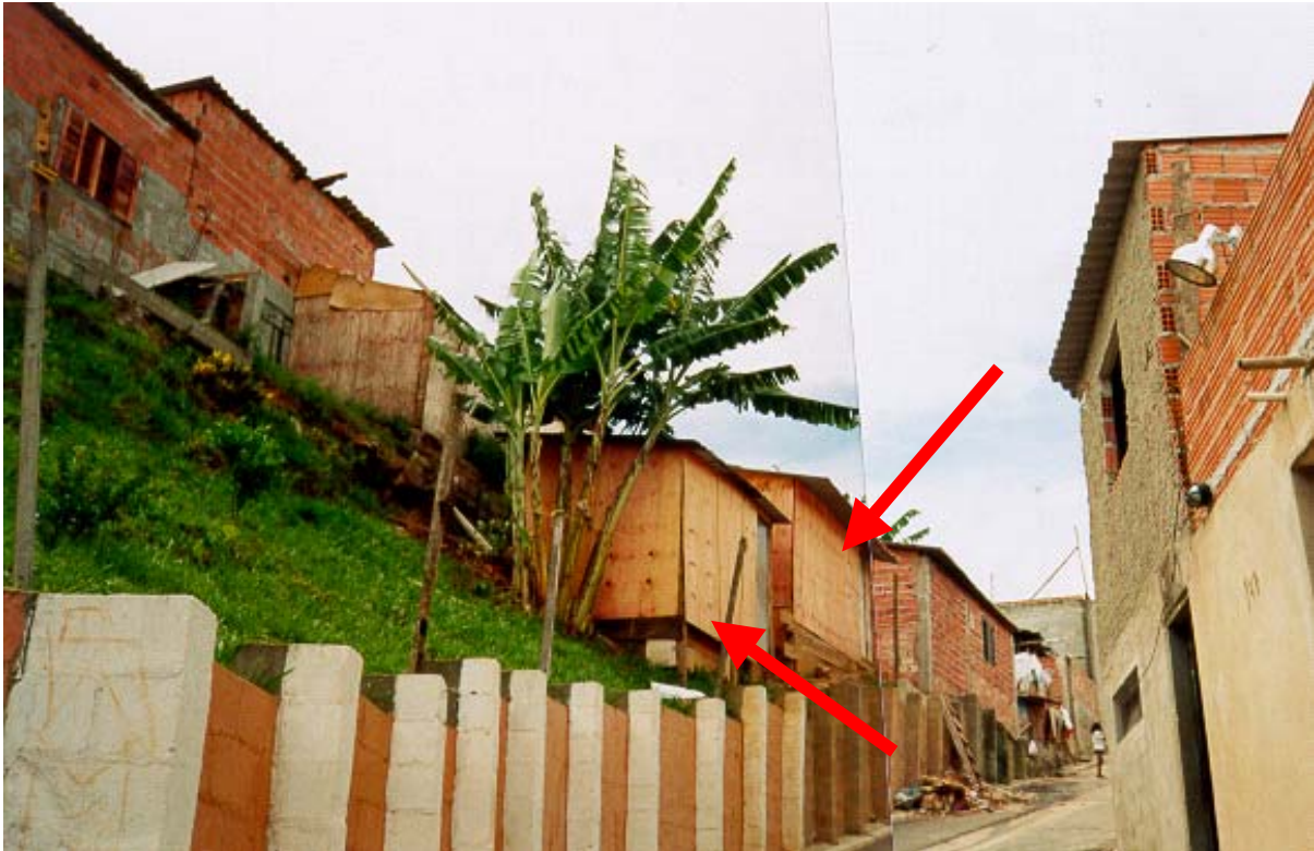
Foto 9 – Construções Inadequadas após os Trabalhos de Urbanização
