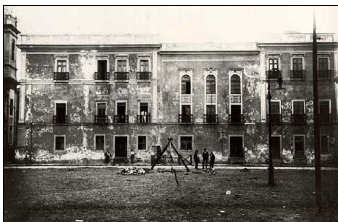
FIGURA 7 – Edifício que ficou conhecido como “Cadeia Velha”, que serviu de sede à Câmara dos Deputados no Rio de Janeiro de 1891 a 1914.
