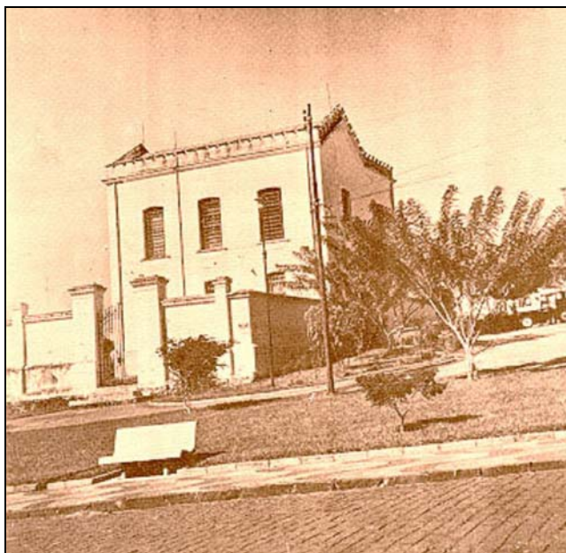
FIGURA 1 – Prédio da Cadeia Pública de Patrocínio Paulista, construído por influência de Estevam Marcolino
