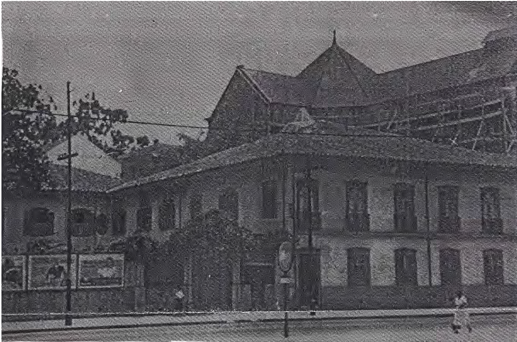
Foto 1 – Casa de Veridiana da Silva Prado, na Rua da Consolação, sobrado de taipa construída no século XVIII, demolida na década de 1940. 91
