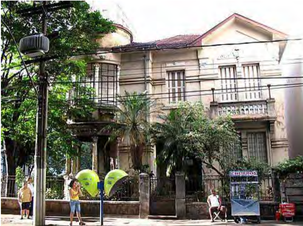
Figura 14 – Palacete Camilo de Mattos, obra de Antônio Soares Romêo, disponível em http://farm4.static.flickr.com/3226/2611147442_7d4d221cd7.jpg . Desconhecemos a data da foto.
