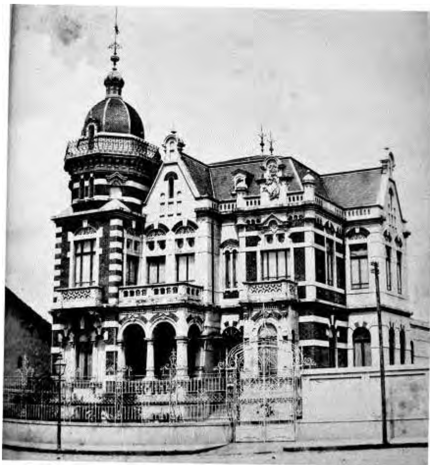
Figura 09 – Residência de Barbosa de Oliveira, projeto de Ramos de Azevedo. Fonte: portfólio Ramos de Azevedo, biblioteca do Condephaat. Foto: João Musa.
