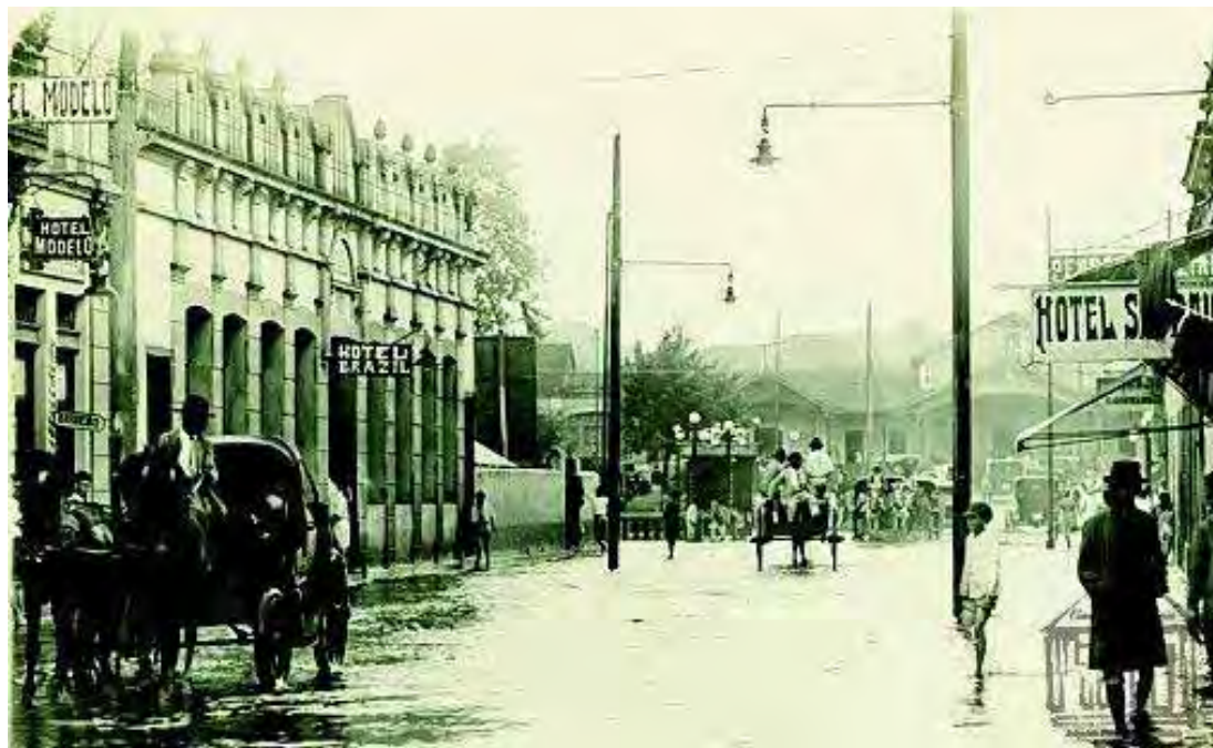
Figura 20 – Vista da Rua General Osório no último quarteirão antes da Avenida Jerônimo Gonçalves durante enchente. Ao fundo Estação Ribeirão Preto da Cia. Mogiana. Foto de Aristides Motta. Fonte: ARHRP; Série Fotos; nº 95.
