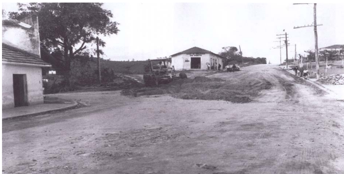
Foto 9 – Asfaltamento do Núcleo Central de Bonsucesso. A fotografia mostra uma máquina preparando o terreno para ser pavimentado e, ao fundo, um bar. Esse provavelmente é o caminho que atualmente liga o núcleo central à Via Dutra. Fonte: AHCG. Autoria: Desconhecida. Data: Sem data (Aproximadamente segunda metade do século XX década de 60/70).
