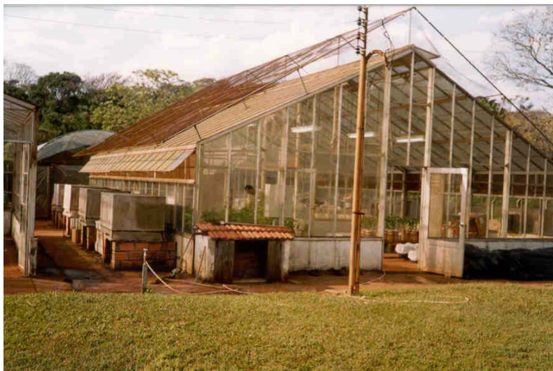
Figura 1. Casa de vegetação de vidro, com equipamento controlador de temperatura e umidade.
