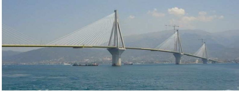
Figura 2.3: Ponte Estaiada Charilaos Trikoupis
