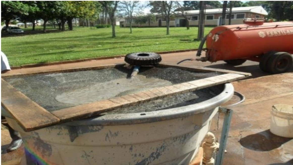
**FIGURA 5.** Pré-tratamento das águas residuárias de suinocultura utilizadas na alimentação dos Reatores UASB.
