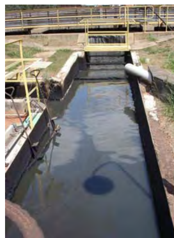
Figura 9. Ponto 6 – entrada do efluente bruto (industrial e doméstico) na estação de tratamento biológico.
