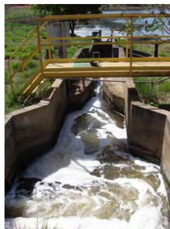
Figura 4. Ponto 2 - entrada do efluente industrial tratado biologicamente na lagoa de estabilização.
