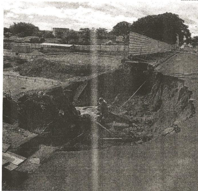
Chuva forte na madrugada dessa quinta-feira (6) causou a abertura de uma cratera de dois metros na Rua 3, Vila Operária
