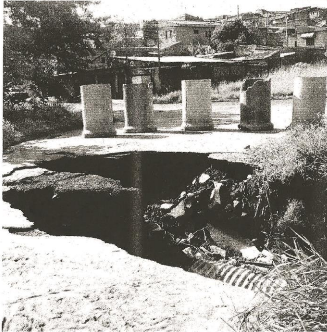
Esse buraco no Jardim Paulista II aumenta de tamanho a cada chuva. Prefeitura municipal comunica que está monitorando a área
