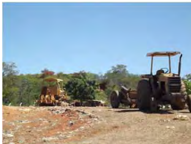
Figura 12. Máquinas utilizadas na cobertura dos resíduos enviados para o aterro sanitário de Lavras da Mangabeira.
