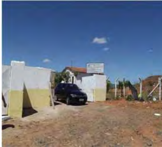
Figura 13. Entrada do aterro sanitário de Lavras da Mangabeira.
