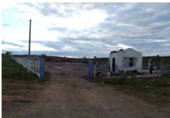
Figura 27. Entrada do lixão municipal de Ipaumirim – CE.
