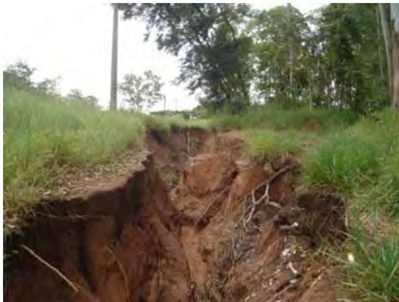
Figura 18: Ravina desencadeada pela concentração do escoamento superficial urbano. (Foto: Barbosa, C. - janeiro, 2010)
