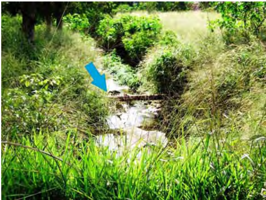
Foto 48: Assoreamento no córrego das Ondas, localizado a jusante do ravinamento da foto 47. Autor: Silveira (2009).
