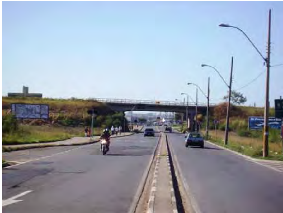
Foto 57: Bairro Santa Terezinha instalado em área mapeada com restrição “média” com base em parâmetros de fragilidade potencial. Autor: Silveira (2009).
