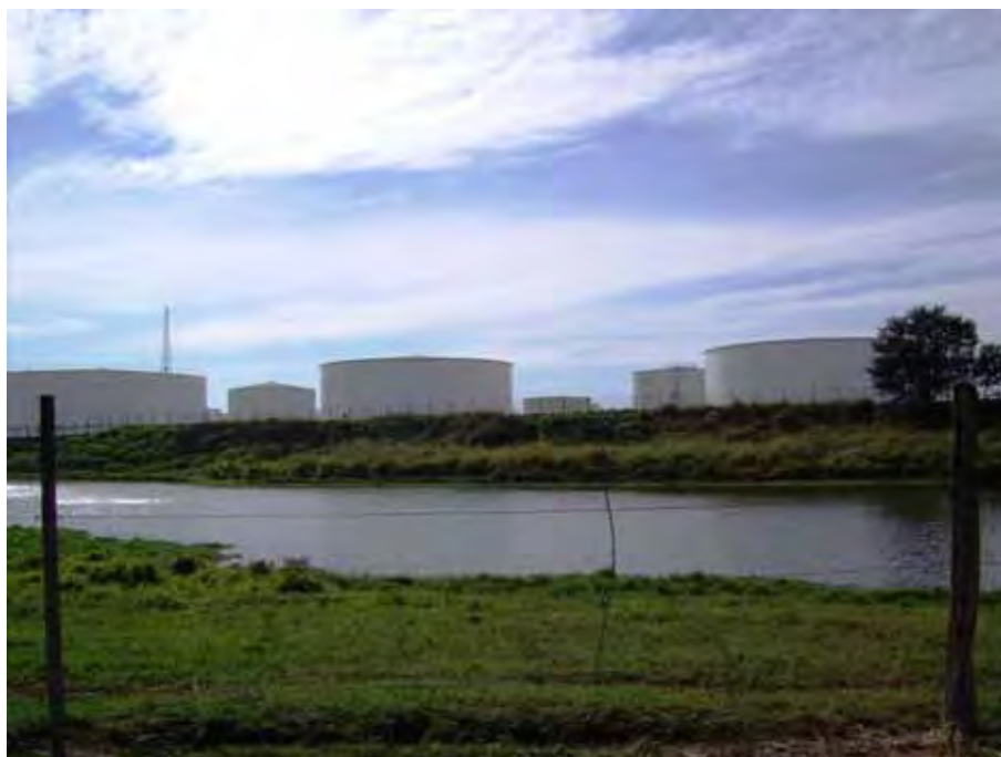
Foto 45: Reservatório em área da Usina Costa Pinto sem qualquer vegetação de entorno (área com restrição “total”).
