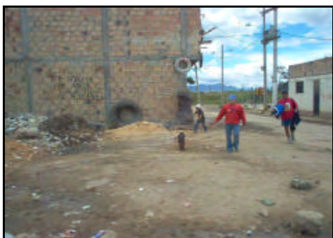
Foto No. 9 - Bairro de origem ilegal
