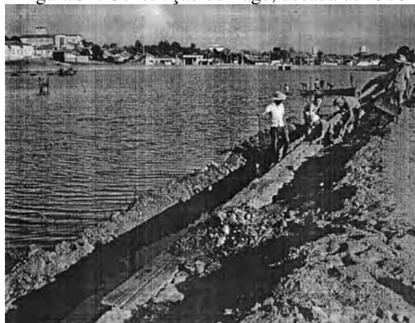
Figura 54: Construção do Lago, década de 1970
