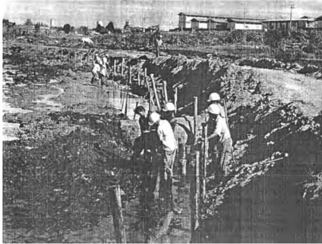
Figura 48: Canalização do Córrego da Servidão, final da década de 1960
