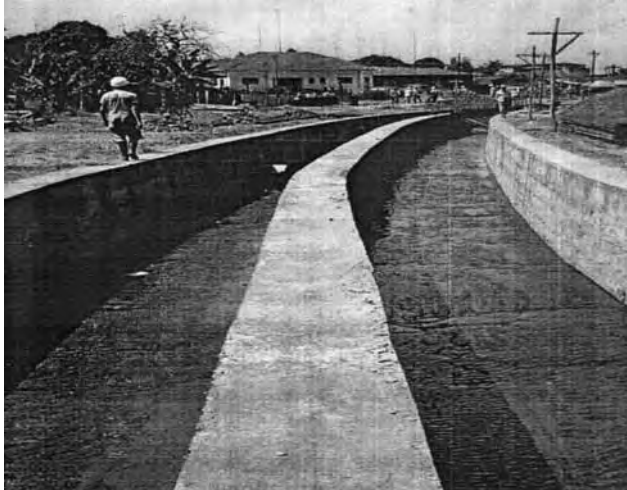
Figura 49: Canalização do Córrego da Servidão, final da década de 1960
