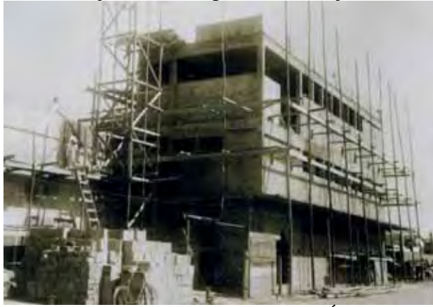
Figura 44: Construção das novas galerias da estação ETA I, em 1968
