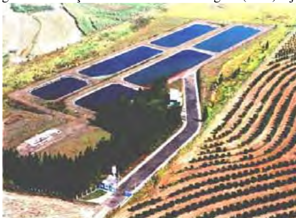
Figura 62: Estação de Tratamento de Esgoto (ETE) Ajapi
