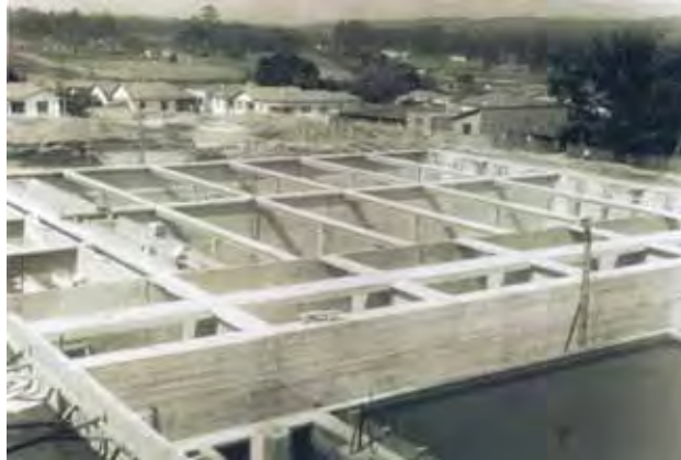
Figura 45: Construção das novas galerias da estação ETA I, em 1968
