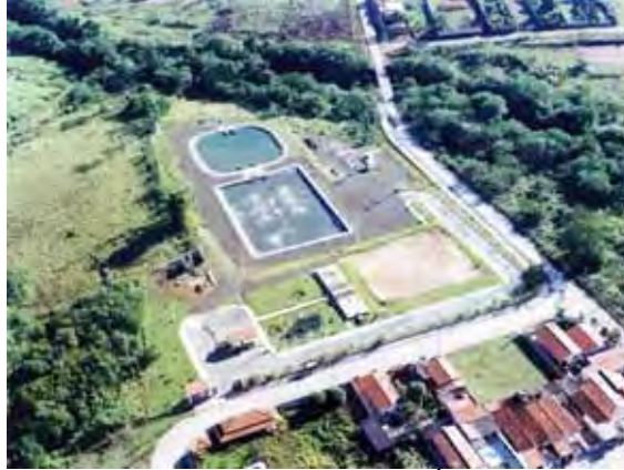
Figura 2: ETE - Estação de tratamento de esgoto
