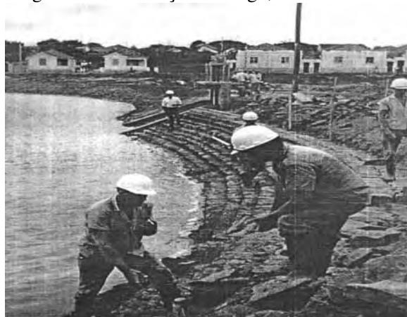
Figura 53: Construção do Lago, década de 1970
