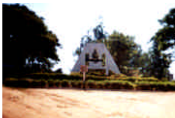
Foto 1 - Entrada da ETE
