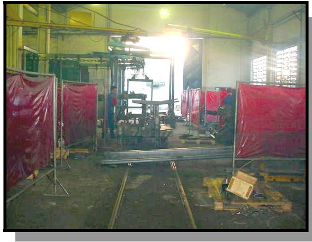
Visão parcial da caldeiraria
