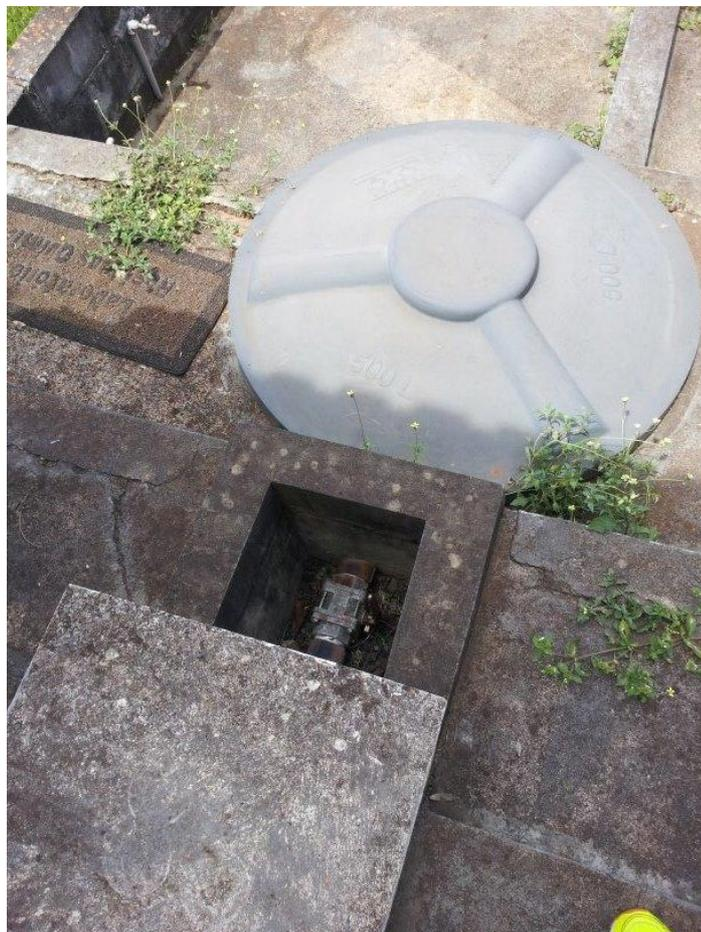
**Figura 26:** Sistema para a retenção de resíduo que possa vir a vazar do depósito.
