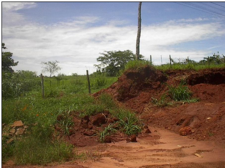
**FOTO 10:** TESTEMUNHO DA ÁREA DE EMPRÉSTIMO 2 - ROTATÓRIA COM CERCA DE 3,5 m EM CORTE
