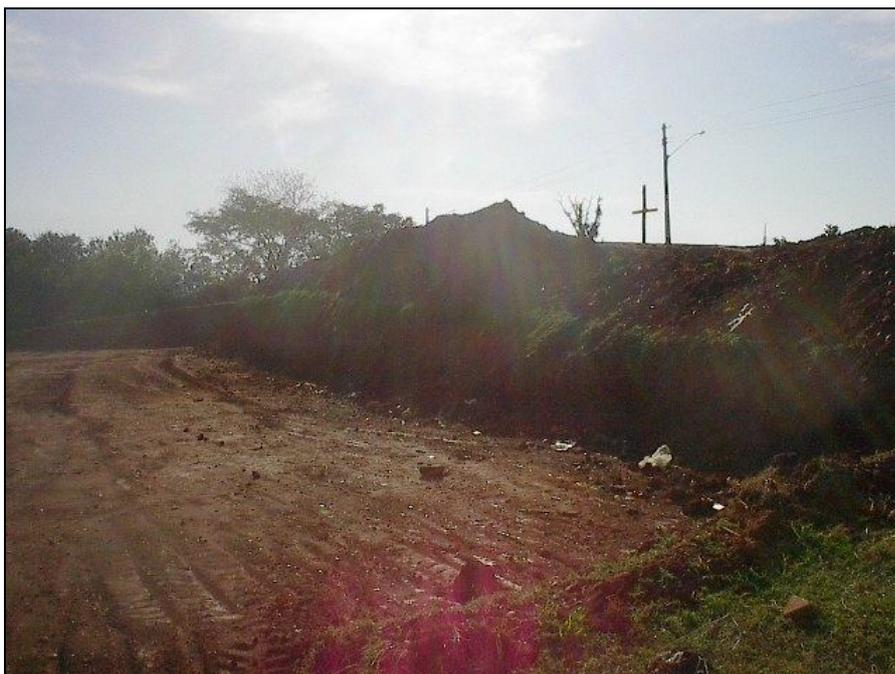
**Figura 19: Detalhe do aterro sendo construído – interface entre talude de corte e talude de aterro**
