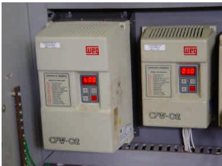
Figura 4-14 - Inversores de Frequência utilizados.
