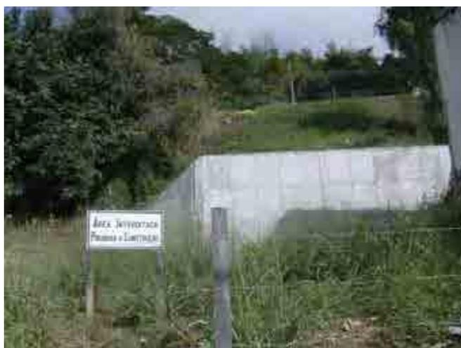
**Figura 24 – Área interdita em um trecho da Rua Anísio Novaes devido à problemas de instabilidade de encosta: Observa-se a estrutura de contenção implantada no talude. Coordenadas do local da imagem: 22° 49,589' S/ 45° 11,248' W. Fonte: Autor.**
