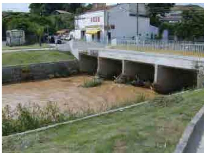
**Figura 12 – Passarela na Avenida José Juvenal M. dos Santos: Observa-se nos pilares da ponte a presença de materiais diversos carreados pelas águas do ribeirão, diminuindo a seção de escoamento, tais como: folhas, gravetos e também lixo proveniente das ocupações irregulares. Fonte: Autor.**
