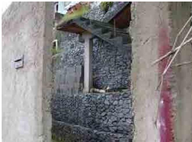
**Figura 37 – Estrutura de contenção em gabiões, construída para manter a estabilidade do talude, localizada em uma residência na Rua Coronel Villagram Cabrita. Fonte: Autor.**
