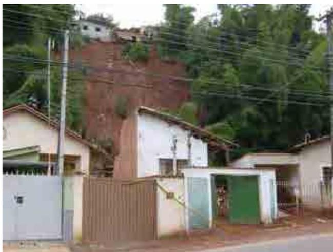
**Figura 45 – Trecho da Rua Coronel Tamarindo, adjacente à Rua Anísio Novaes, no Bairro da Pedreira, onde um deslizamento de solo provocou a destruição de casas na base da encosta e interdição, pela defesa civil, de várias outras. Fonte: Autor.**
