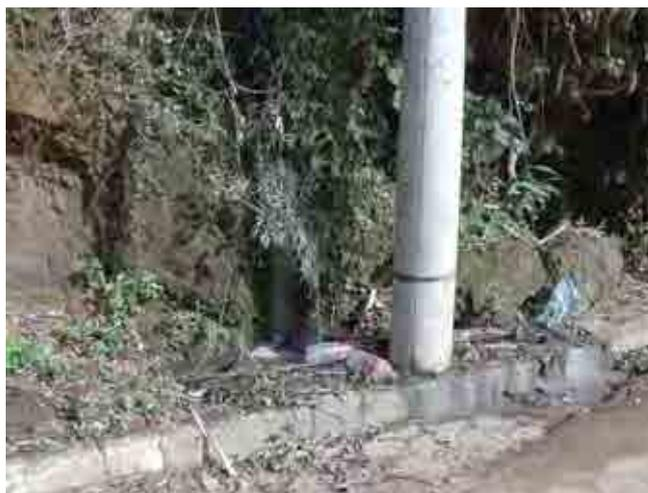
**Figura 19 – Esgoto que corre através do talude, desembocando na sarjeta da Rua Anísio Novaes e contaminado o solo. Coordenadas do local da imagem: 22° 49,626' S/ 45° 11,230' W. Fonte: Autor.**
