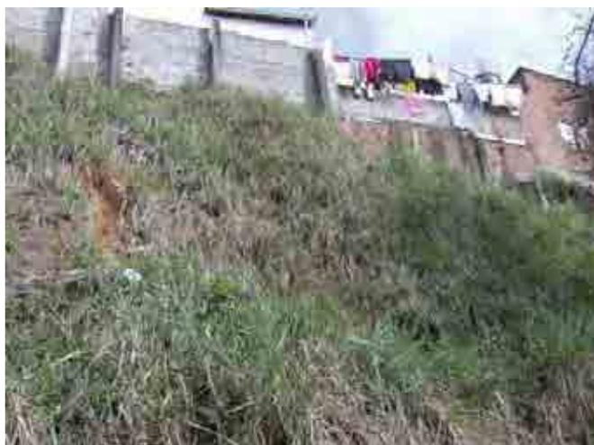
**Figura 25 – Casas construídas na proximidade do talude, com alguns pontos de solo exposto e despejo de esgotos e águas pluviais diretamente na superfície da encosta. Coordenadas do local da imagem: 22° 49,554' S/ 45° 11,260' W. Data de registro da imagem: 06/07/09. Fonte: Autor.**
