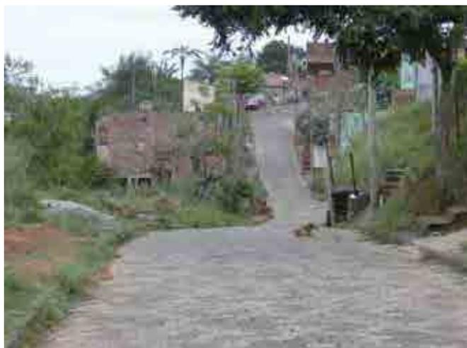
**Figura 35 – Vista parcial da Rua Coronel Villagram Cabrita. Observa-se na área central da rua que concentra as águas pluviais. Fonte: Autor.**
