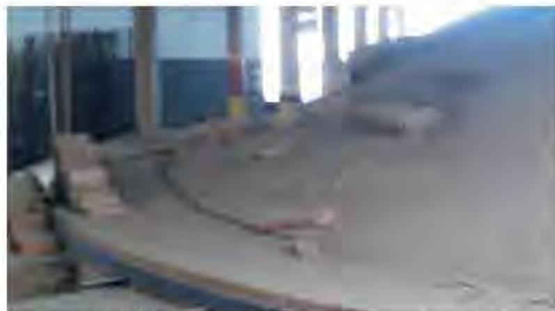
**Figura 57: Tijolos desprendidos da abóboda em forno circular.**
