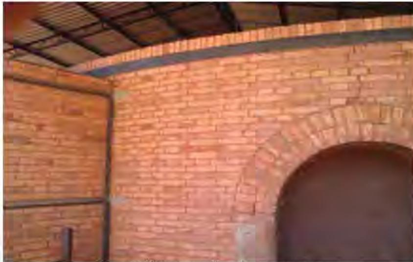
**Figura 31: Cínta metálica de travamento.**
