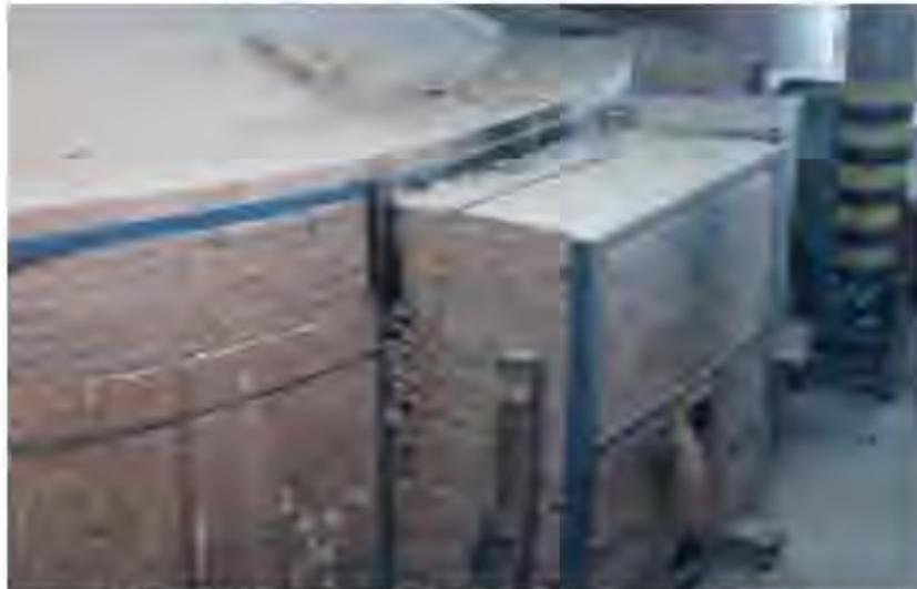
**Figura 51: Fomalha desconjuntada da parede do forno.
