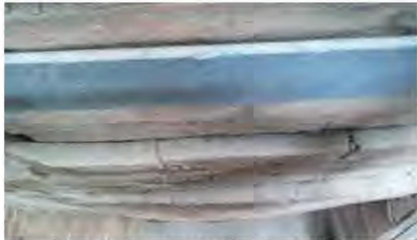
**Figura 56: Degraus gerados pelas fissuras horizontais.**
