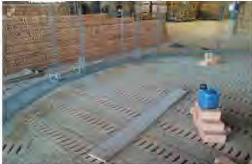
**Figura 30: Viga baldrame e ferragens para os pilares de ligação.**
