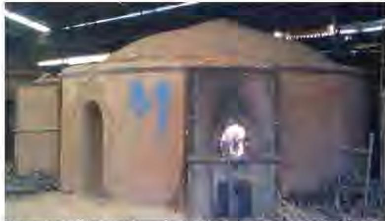
**Figura 58: Abóboda deformada devido ao longo tempo de utilização.**
