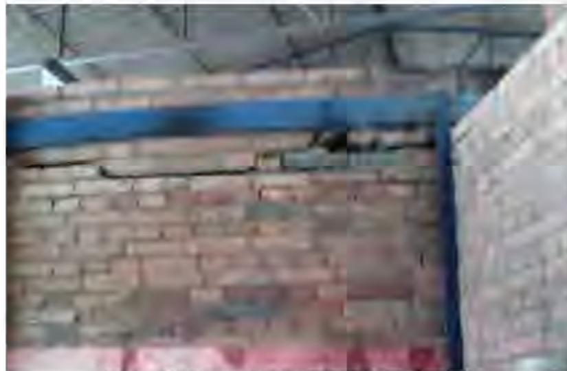
**Figura 55: Fissura horizontal em forno circular.**
