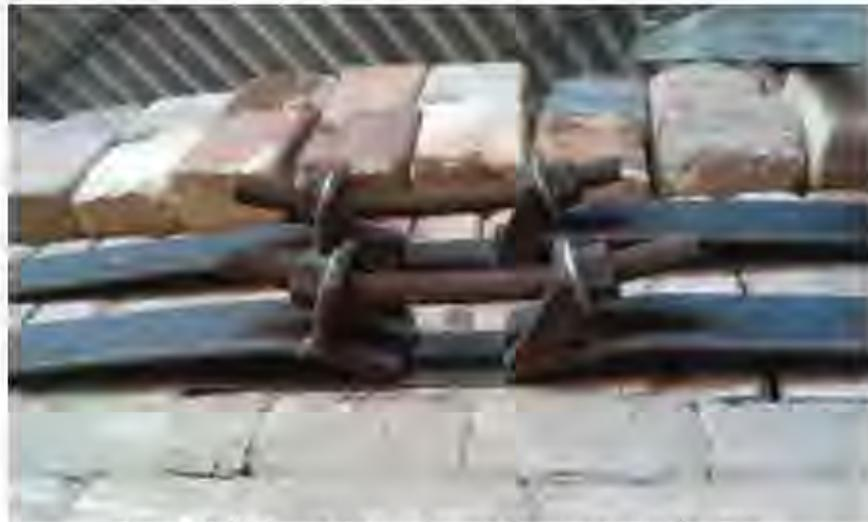
**Figura 49: Deformação no sistema de travamento da cinta.**
