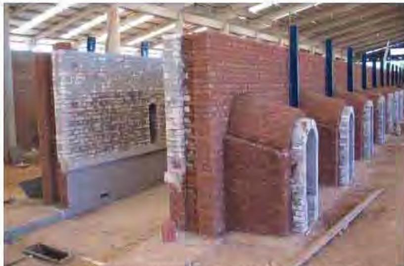
**Figura 43: Forno construído com as paredes internas de refratários.
