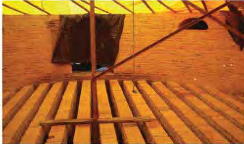
**Figura 39: Bancas de interligação do forno circular.**
