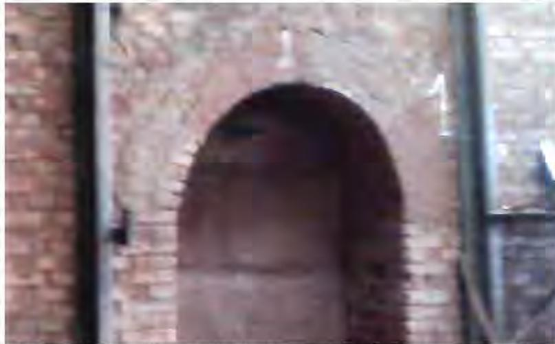
**Figura 42: Arco da porta do forno - exemplo de abertura na parede.
