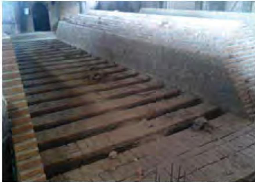
**Figura 40: Construção das paredes laterais do forno paulistinha.
