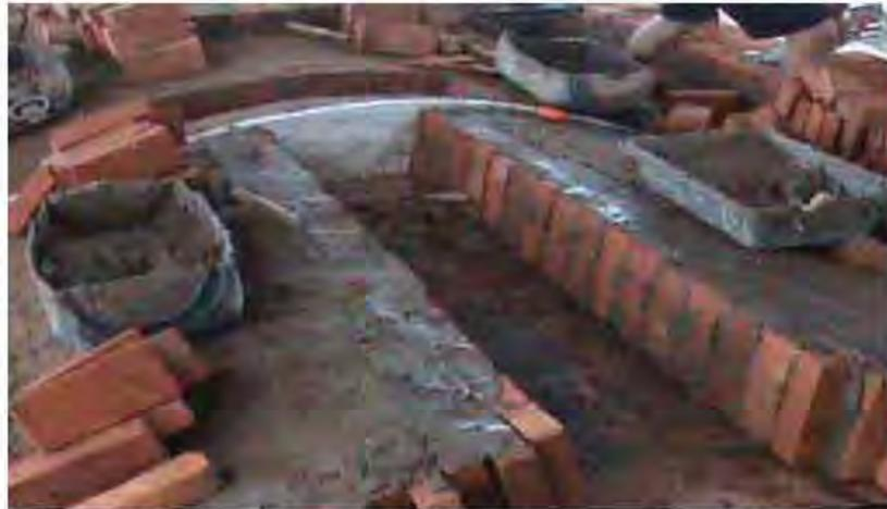
Figura 46: Execução de arco em forno túnel – tijolos assentados com amarramento, sem juntas verticais.
