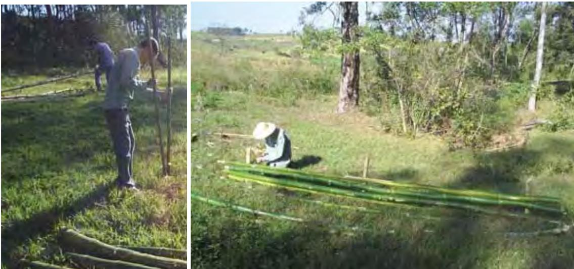
Figura 4: Montagem da barreira a montante da Ravina 1.
