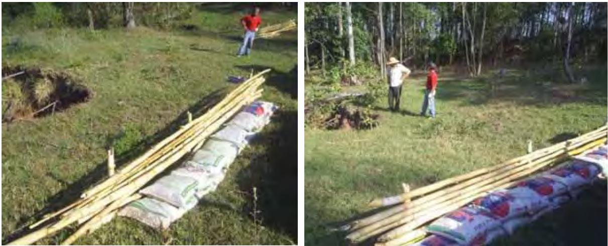
Figura 8: Barreiras posicionadas a montante da Ravina 2 (esquerda) e da Ravina 1 (direita).
