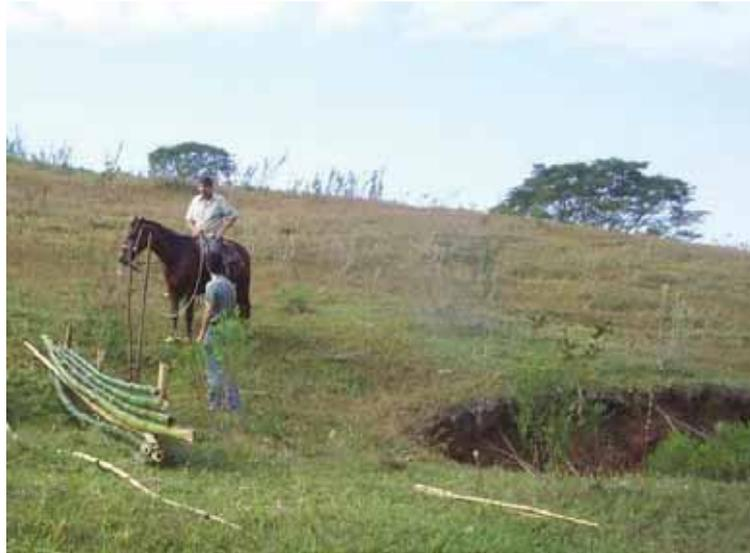
Figura 5: Barreira da Ravina 2, parcialmente montada.
