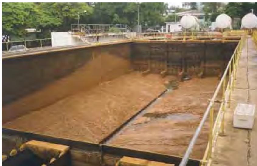
**Figura 3.1:** (a) Foto aérea dos três decantadores da ETA/SABESP de Presidente Prudente-SP e (b) fotografia do decantador onde foi coletado o lodo.
