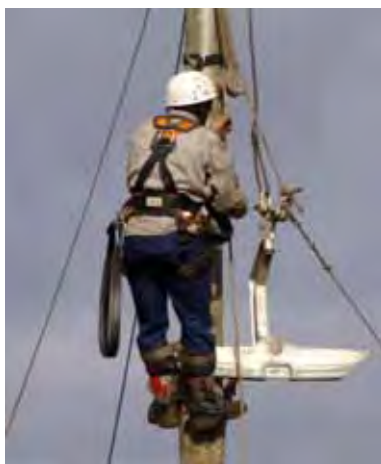
Figura 18. Instalação do suporte do cabo mestre (peça “G”).
