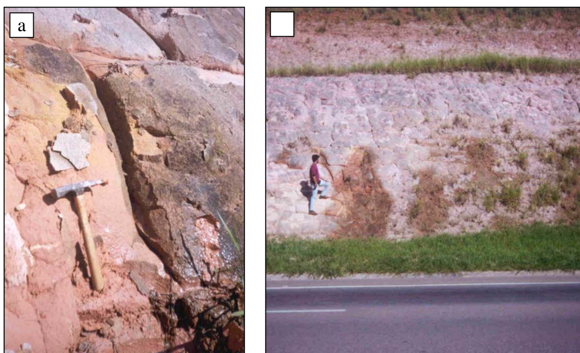
Fotos 6.1: Afloramento na Rodovia Santos Dumont, próximo ao Aeroporto Internacional de Viracopos. Existem (a) nascentes nas juntas de uma camada de arenito do Grupo Itararé e (b) nascentes no contato entre a camada de arenito e diamictito com matriz argilosa (encobertas pela vegetação).
