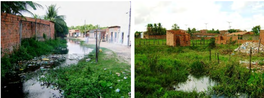
Figura 4.39 – A falta de infraestrutura, principalmente coleta de esgoto e lixo, e sistema de drenagem, se apresentam entre os principais problemas das comunidades do Vila Velha.
