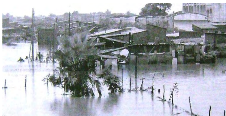
Figura 4.88– Os danos causados pelas inundações foram sentidos em toda a cidade de Fortaleza, mas as comunidades mais pobres são as mais vulneráveis e mais susceptíveis aos riscos, caso da comunidade Frifort, no Conjunto São Miguel. Fonte: Jornal O Povo , 30 jan 2004.
