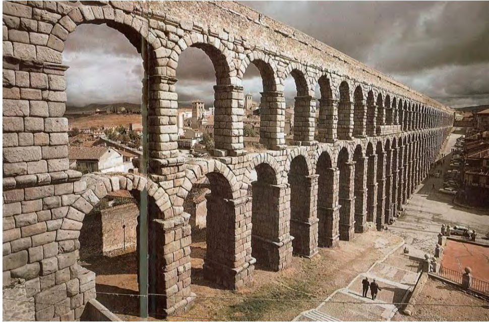
Figura 2.15 – Aqueduto de Segóvia (Espanha). Seus 128 arcos atravessam o centro da cidade ao longo de 800 metros. Fonte: extraído de Cornell e Matthews (1996).
