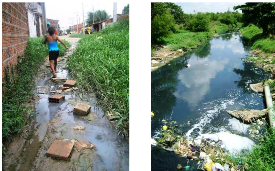
Figuras 4.72 e 4.73 – Precárias condições de infraestrutura na comunidade Parque Jerusalém (e). Fonte: foto do autor, janeiro de 2008. Intensa poluição do riacho Alto Alegre na comunidade Jardim Fluminense. Notar coloração escura da água e o lixo (d). Fonte: foto do autor, setembro de 2009.
