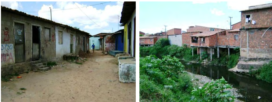
Figura 4.58 e 4.59 – Moradias precárias “adaptadas” às frequentes inundações através de aterros nos alicerces, na comunidade do Capim (e). Ocupação crescente do leito principal do afluente do rio Maranguapinho por palafitas (d). Fonte: fotos do autor, agosto de 2009.
