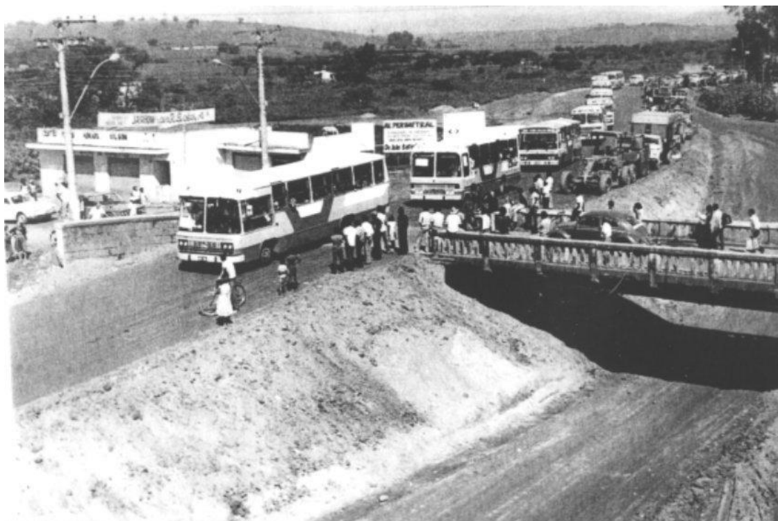
Figura 31 – Obras para implantação da Avenida Perimetral, no início da década de 80.
