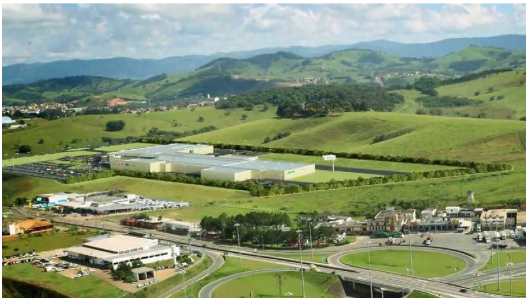
Figura 68 – Shopping Center Serra Sul , próximo ao entroncamento da BR-459 com a Fernão Dias, em 2013.
