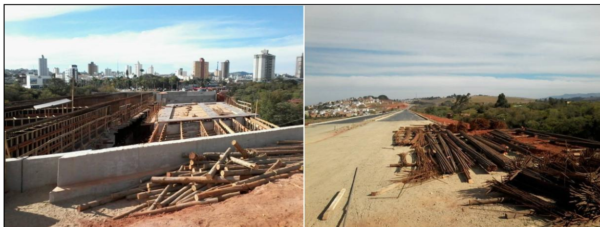
Figura 64 – Construção da avenida “Dique 2”, em Pouso Alegre, no ano de 2013.
