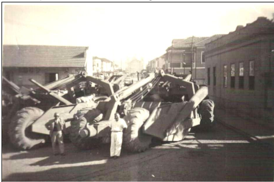
Figura 23 – Máquina utilizada na construção da rodovia Fernão Dias exposta nas proximidades da estação ferroviária de Pouso Alegre, na década de 50.
