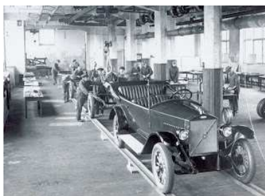
Figura 16: Linha de montagem automobilística nos seus primórdios.
