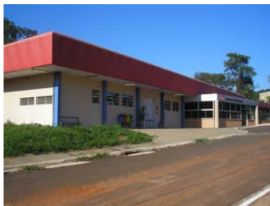
Figura 193: Fachada do Laboratório Didático de Materiais e Protótipos anexado ao CADEP.
