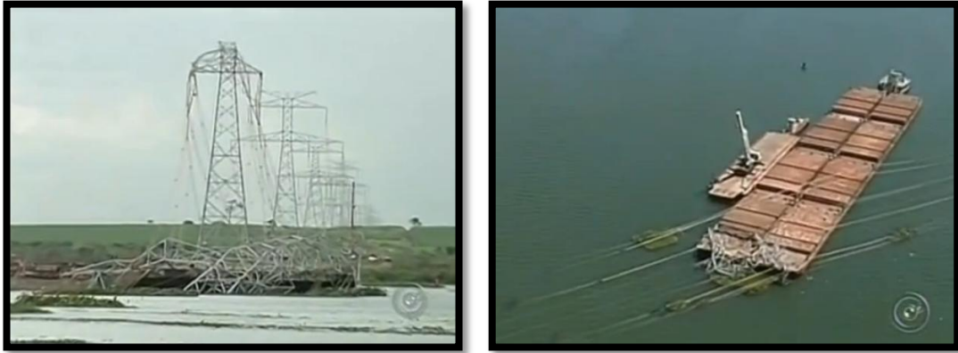
Figura 3 - Choque da Barcaça na Torre de Transmissão na Hidrovia Tietê- Paraná.
