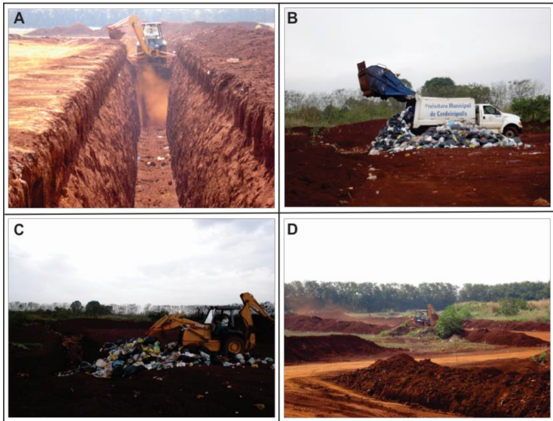
Figura 2 - Etapas de operação do aterro: (A) Abertura de vala; (B) Descarga de resíduos; (C) Lançamento e cobertura dos resíduos; (D) Valas finalizadas.
