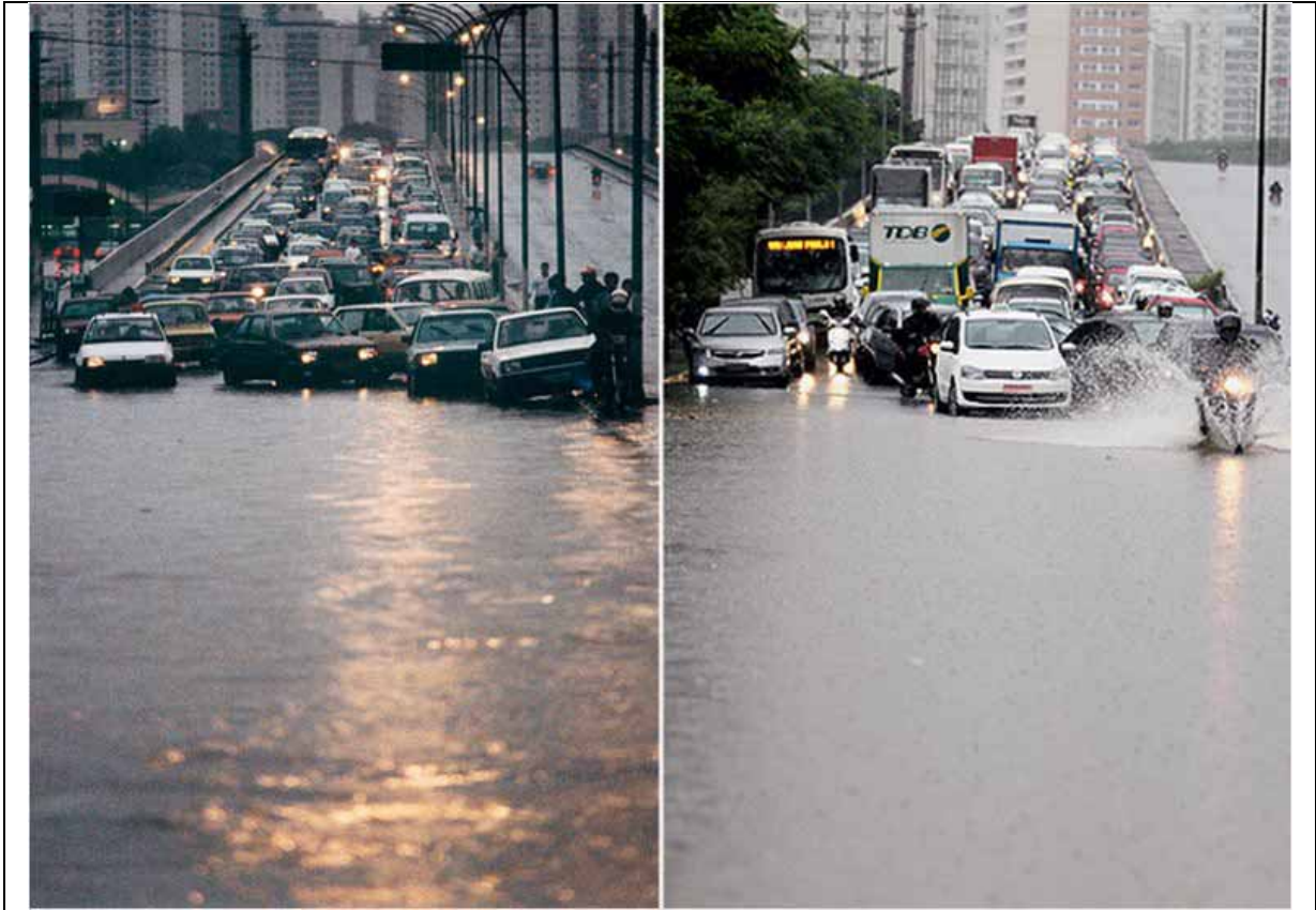
O Viaduto Antártica em 1996 (à esq.) e em 2013: nenhuma mudança Foto: Agência Estado/Fernando Sampaio e Filipe Araújo
