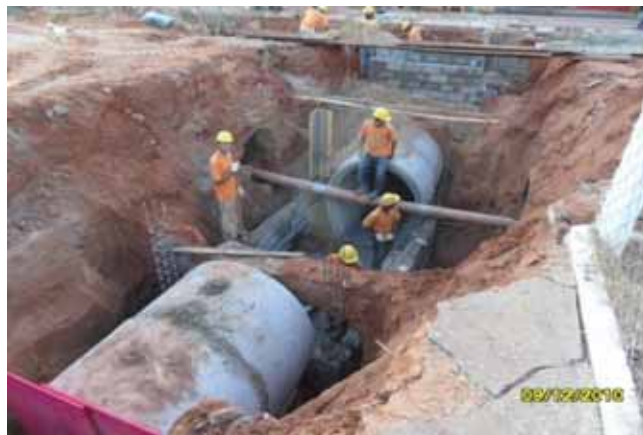
Troca e Ampliação da Rede Pluvial Fonte: SEPLIN, 2012
