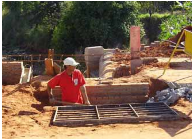
Construção e Manutenção das Bocas de Lobo Fonte: SEPLIN, 2012.
