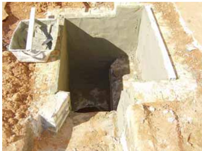
Figura 61 – Obra no Sistema de Microdrenagem
