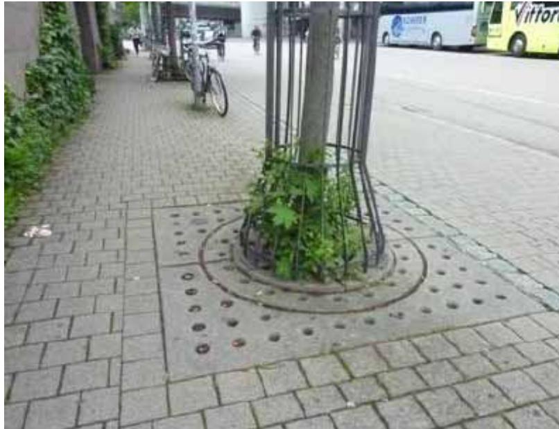
Foto 38 - Piso Poroso na Calçada e na Gola da Árvore.
