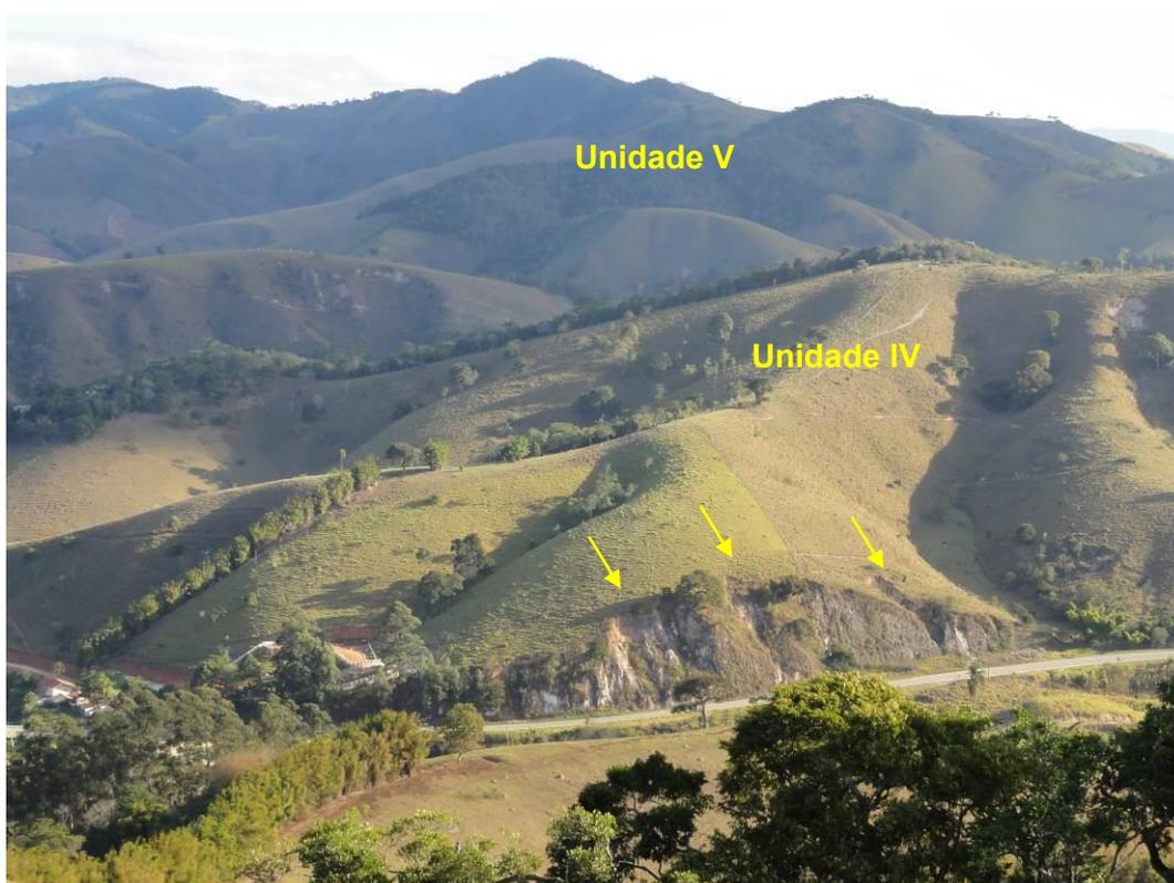
Figura 5.15: Mares de morros representativos da Unidade IV e seu contraste com os morros mais elevados da Unidade V. Os taludes de corte são altos e desenvolvem processos erosivos de grande porte, na forma de sulcos profundos e deslizamentos planares e em cunha, como destacado em talude de corte da SP-125.
