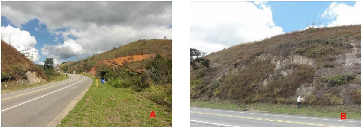
Figura 5.21: (A) morros representativos da Unidade VII em área de corte/aterro da rodovia SP-125; (B) desenvolvimento de movimentos de massa em talude de corte em rocha alterada da Unidade VII.
