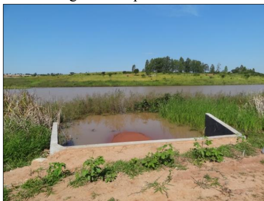
Figura 49. Nível de assoreamento das margens da represa em 2013.
