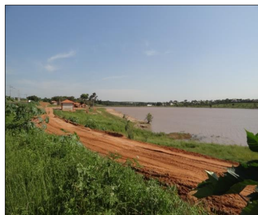
Figura 43. Construção de quiosques e áreas de lazer no entorno da represa em Pres. Prudente.
