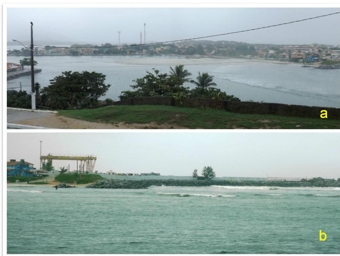
Figura 30: Canal da Barra Franca de Saquarema: **a)** vista do Canal da Barra Franca, área requerida para exploração de areia; **b)** vista do molhe de pedras, construído para ligar permanentemente as águas do mar e da lagoa de Saquarema. Fonte: arquivo pessoal.
