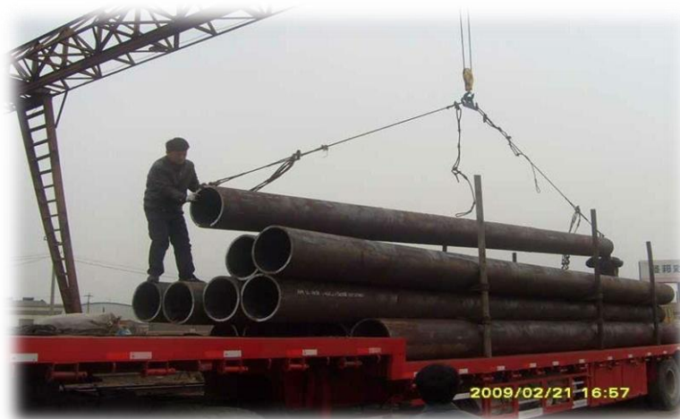
Figura 1: Dutos empilhados prontos para a conexão ou soldagem.
