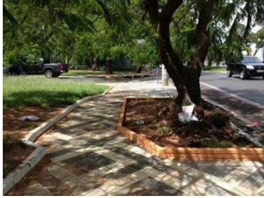
Figura 103 - Ausência de rebaixamento de guia e visão de aproximação dos veículos
