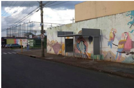
Figura 88 - Ausência de sinalização tátil no ponto de ônibus
