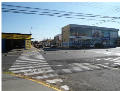
Figura 29 - Ausência de rebaixamento de guia
