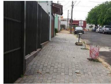
Figura 106 - Presença de grelha na faixa livre
