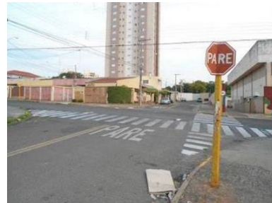
Figura 89 - Ausência de rebaixamento de guia e sinalização vertical de travessia
