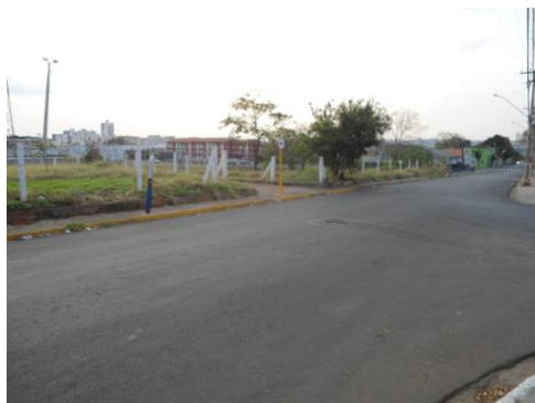
Figura 28 - Ausência de banco e espaço para cadeira de rodas e sinalização tátil
