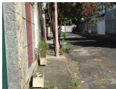
Figura 99 - Largura efetiva da calçada inadequada devido à obstrução permanente
