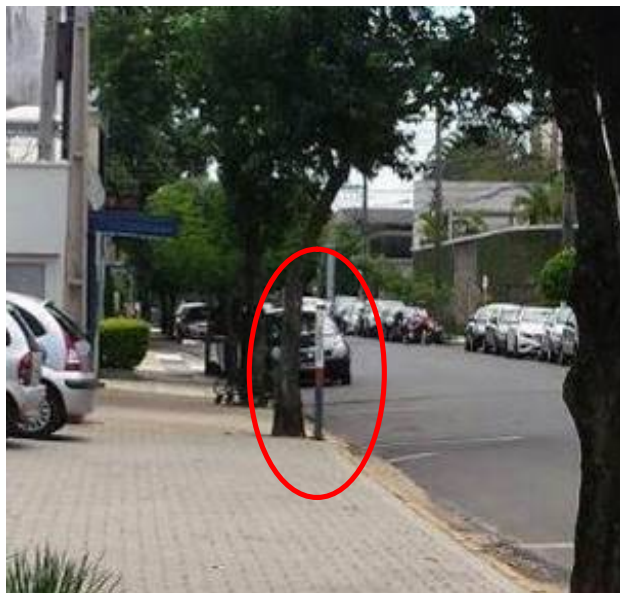
Figura 41 - Pontos de ônibus sem sinalização tátil, informações, espaço para cadeira de rodas e banco
