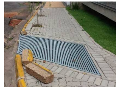
Figura 106 - Presença de grelha na faixa livre
