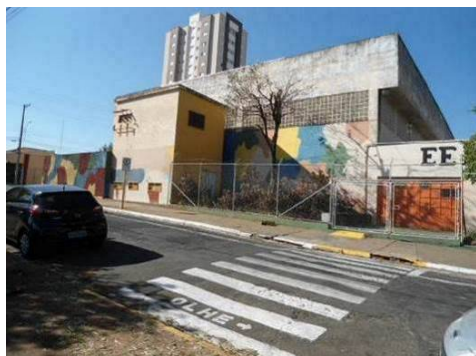
Figura 26 - Ausência de rebaixamento de guia e de sinalização vertical de travessia escolar
