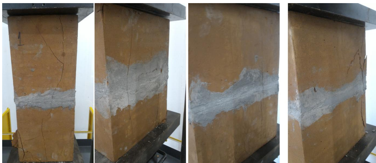
Figura 56- Fissuras verticais características dos prismas – traço 1
