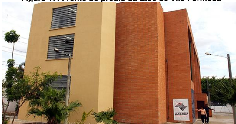
Figura 17: Frente do prédio da Etec de Vila Formosa
