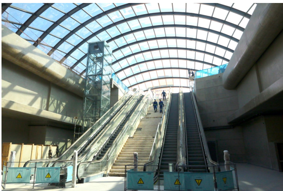
Figura 36 - Obras na Estação Brooklin, na Zona Sul de São Paulo (2017)
