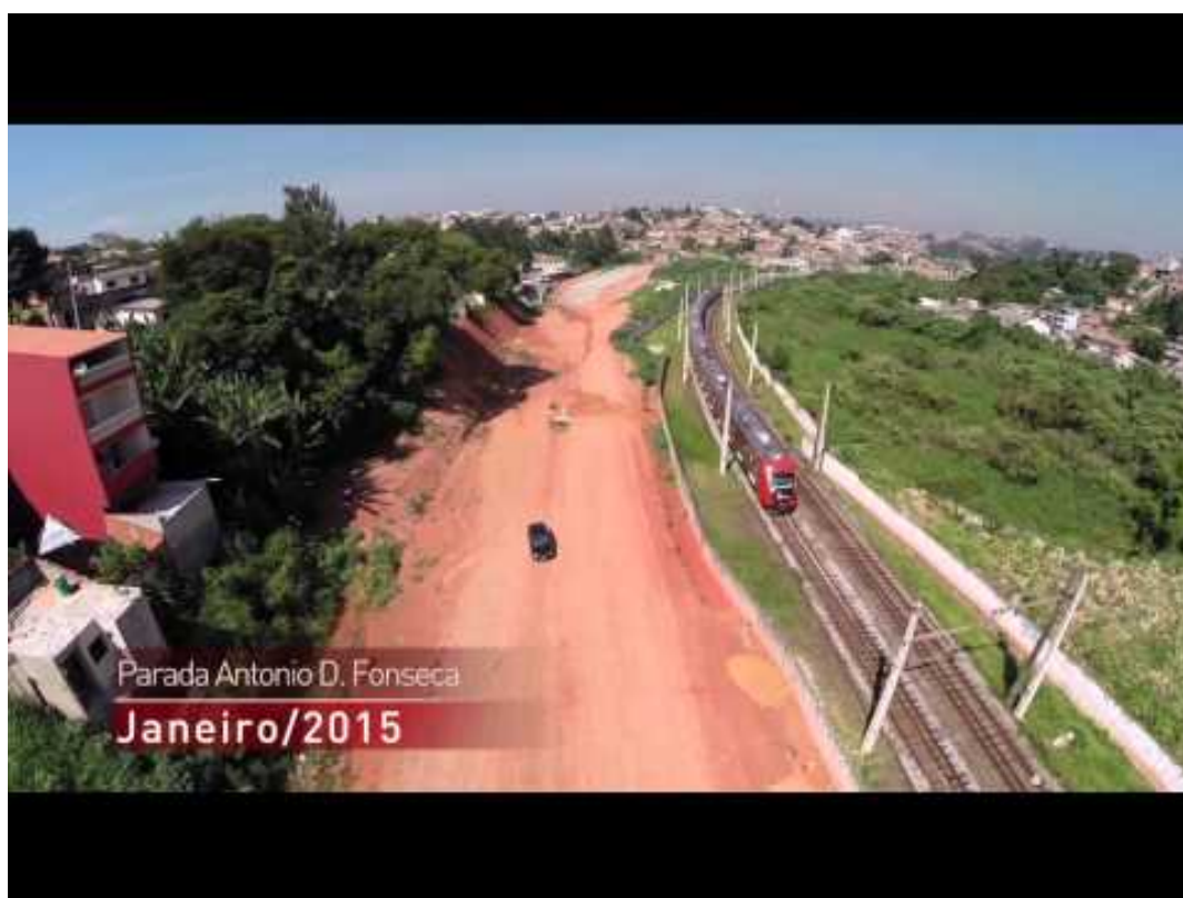
Figura 50 - Imagem aérea das obras do Corredor Metropolitano Itapevi-São Paulo, entre Itapevi e Jandira, junto à faixa de domínio da L8-Diamante da CPTM (2015)
