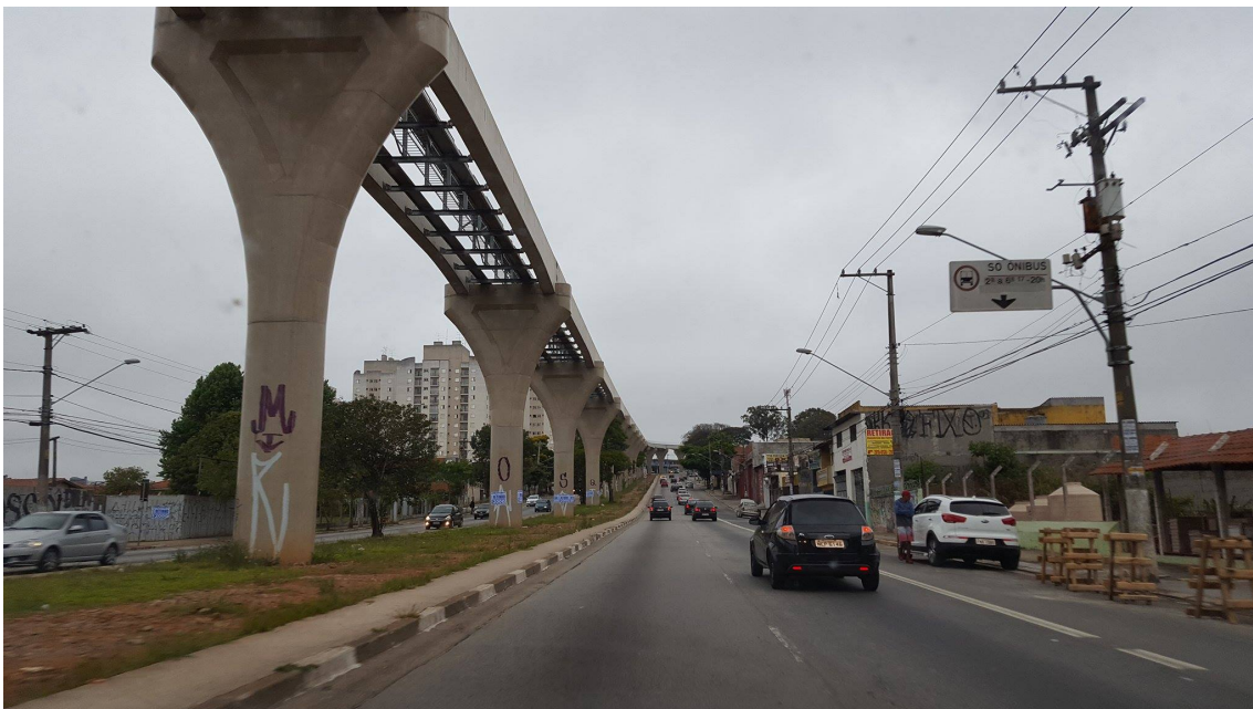
Figura 38 - Obras do monotrilho da L15-Prata, na Zona Leste de São Paulo (2016)
