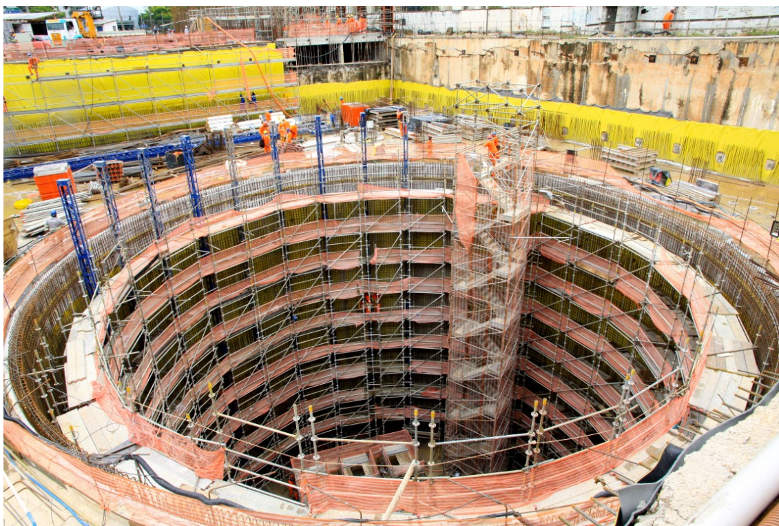
Figura 35 - Obras da Estação São Paulo-Morumbi, na Zona Oeste da Capital (2017)
