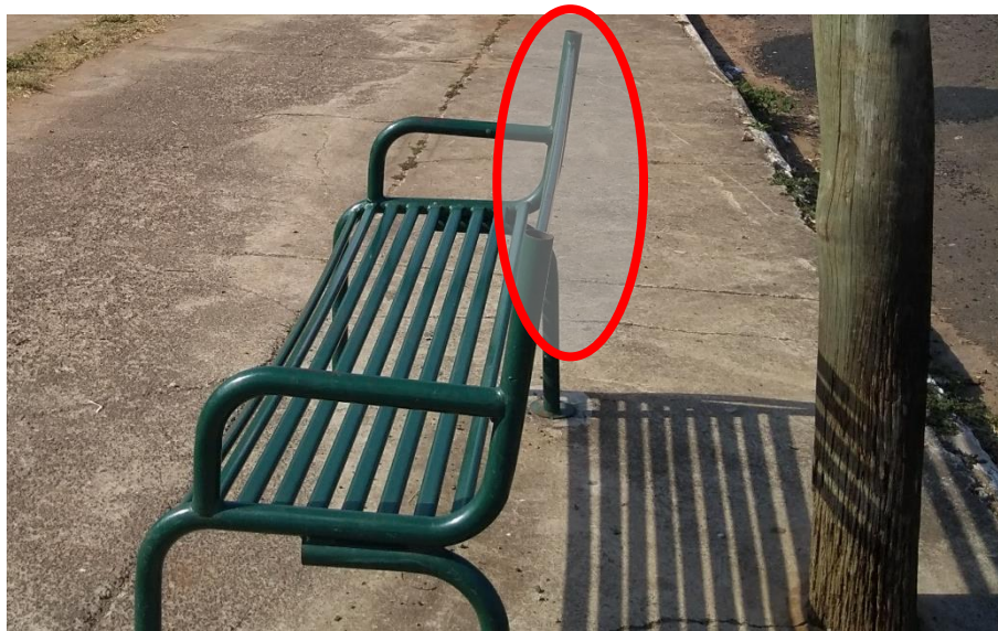
Figura 32 – Banco na AAL 21 parcialmente danificado na parte superior
