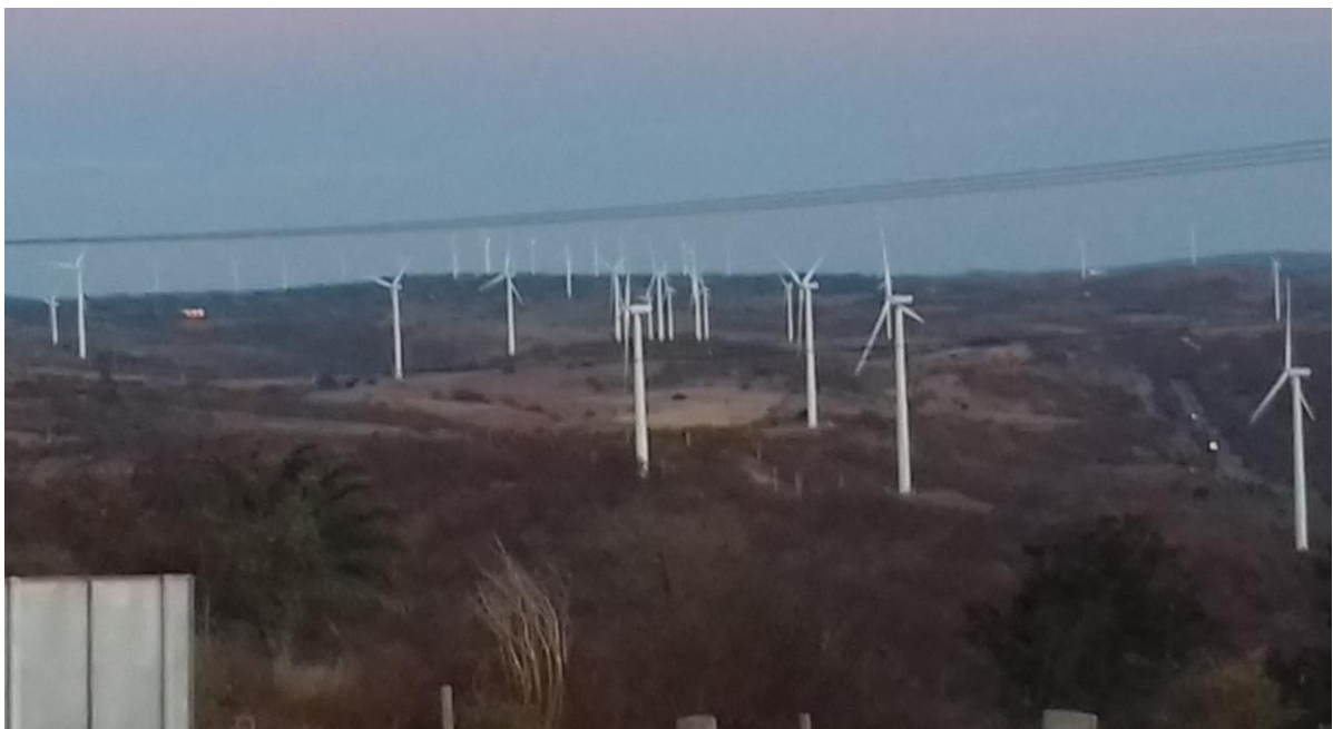
Figura 4- Parque Eólico Complexo Alto Sertão
