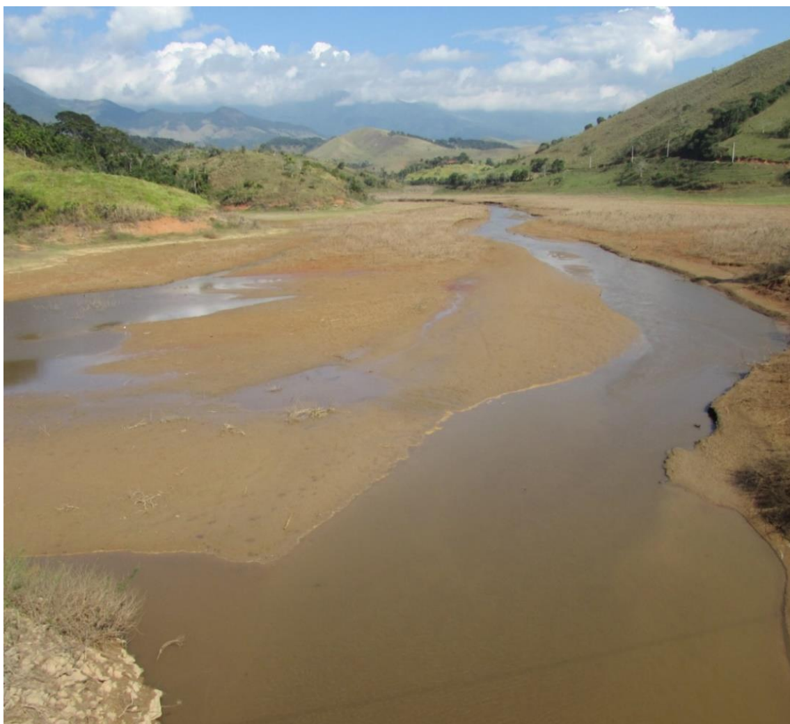
Figura 13 - Assoreamento de parte da represa da Usina do Funil - São José do Barreiro
