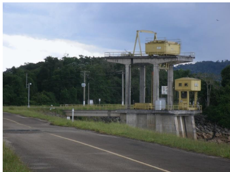
Figura 11 - Tomada de água da represa de Paraibuna
