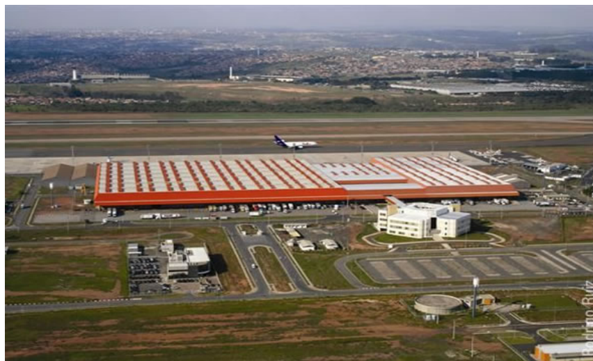
Foto 45: Terminal de Cargas Aeroporto Viracopos
