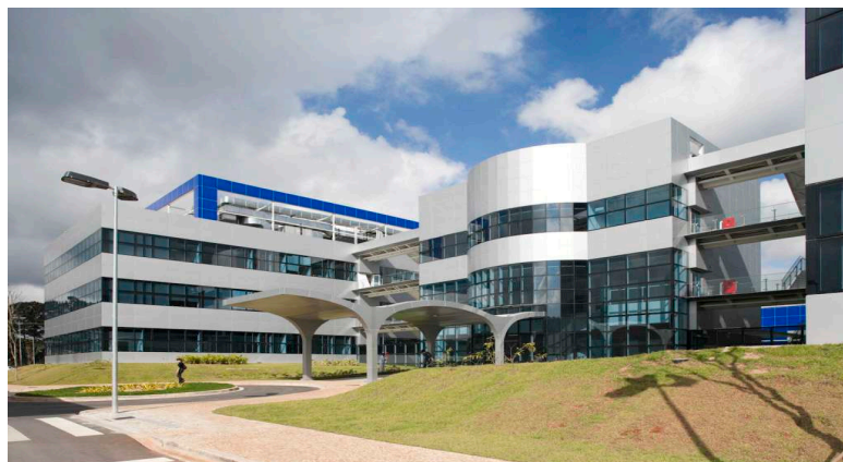
Foto 19: Prédios Anexos Firmenich
