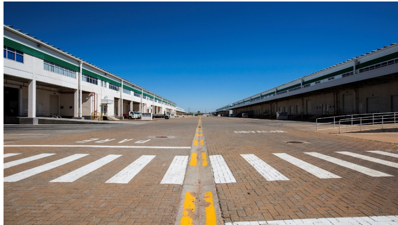
Foto 18: Pátio Interno GLP Campinas
