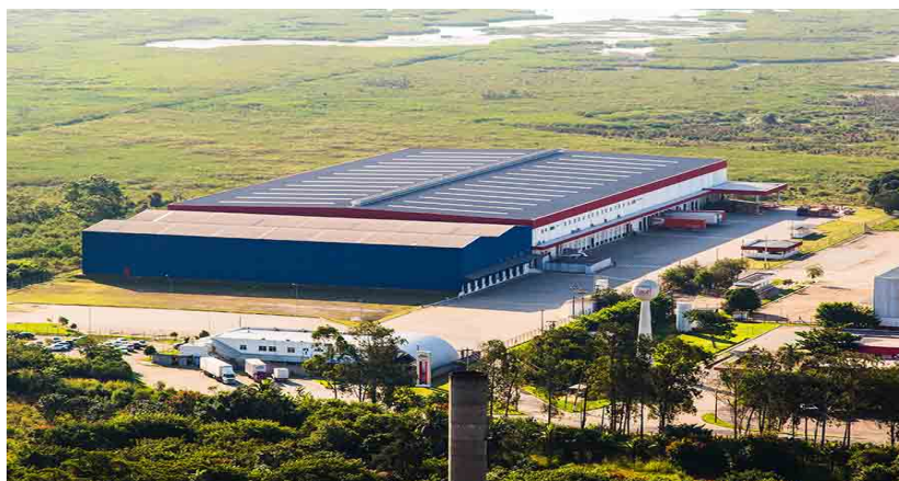
Foto 23: Centro de Distribuição Resende - RJ
