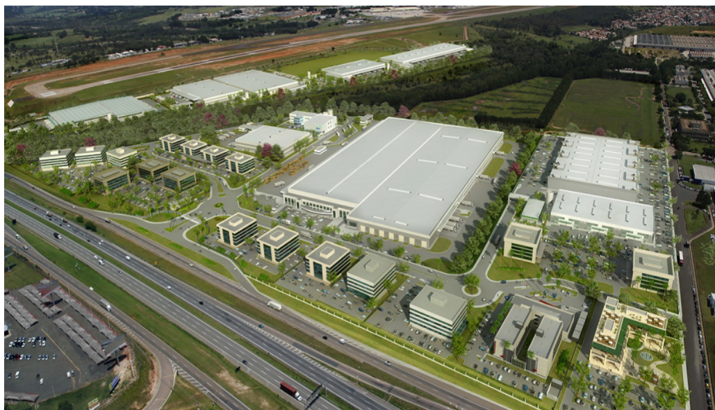
Figura 20: Vista 1 Projeto Concluído
