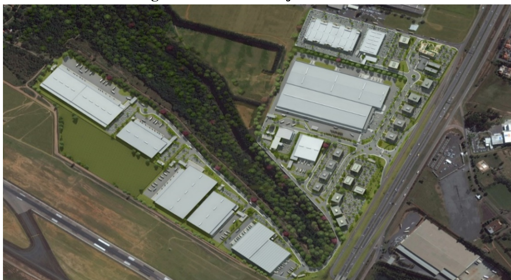
Figura 21: Vista 2 Projeto Concluído
