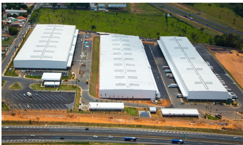
Foto 16: Vista Aérea - LOG Hortolândia
