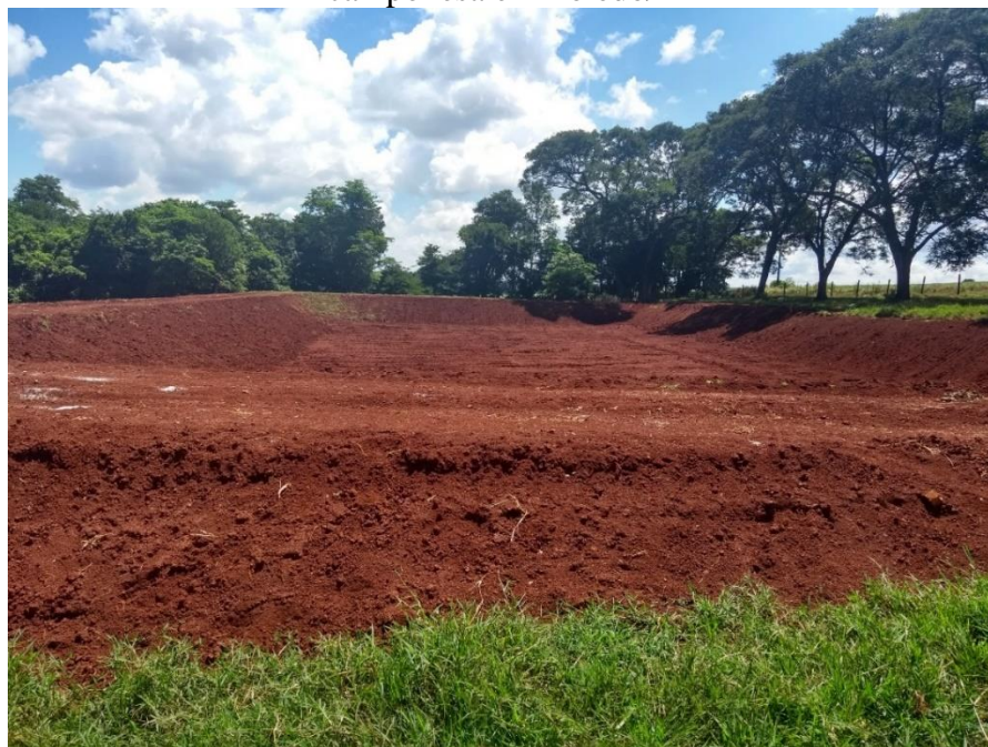
Figura 41: Preparação da terra para a construção de viveiro escavado em propriedade camponesa em Toledo/PR
