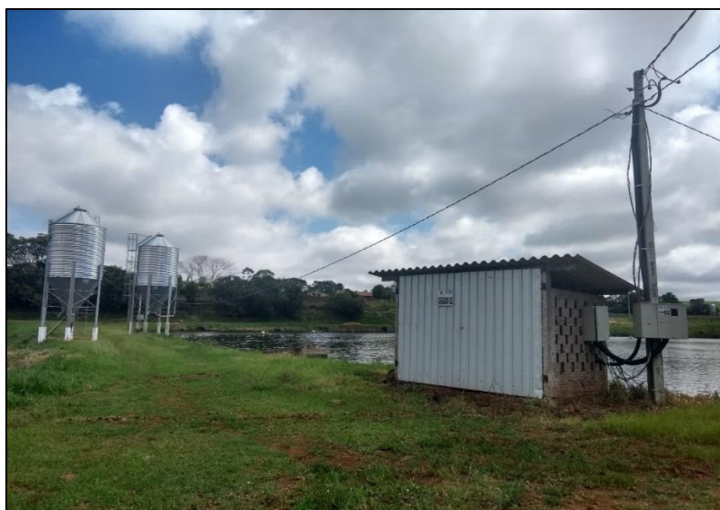
Figura 16: Eletricidade, gerador e silos de armazenamento de ração com dispositivo de alimentador automático
