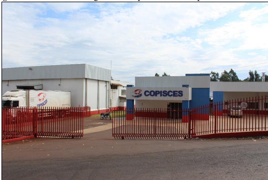
Figura 20: Fachada do frigorífico de pescados da Copisces em Toledo/PR
