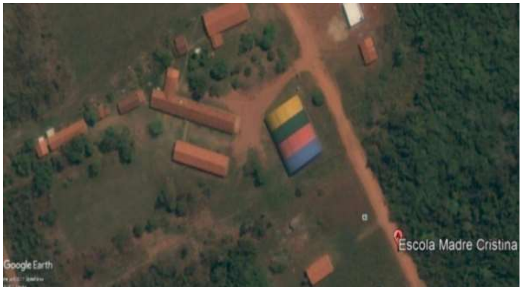
Figura 2 - Vista panorâmica do atual espaço escolar EEMC
